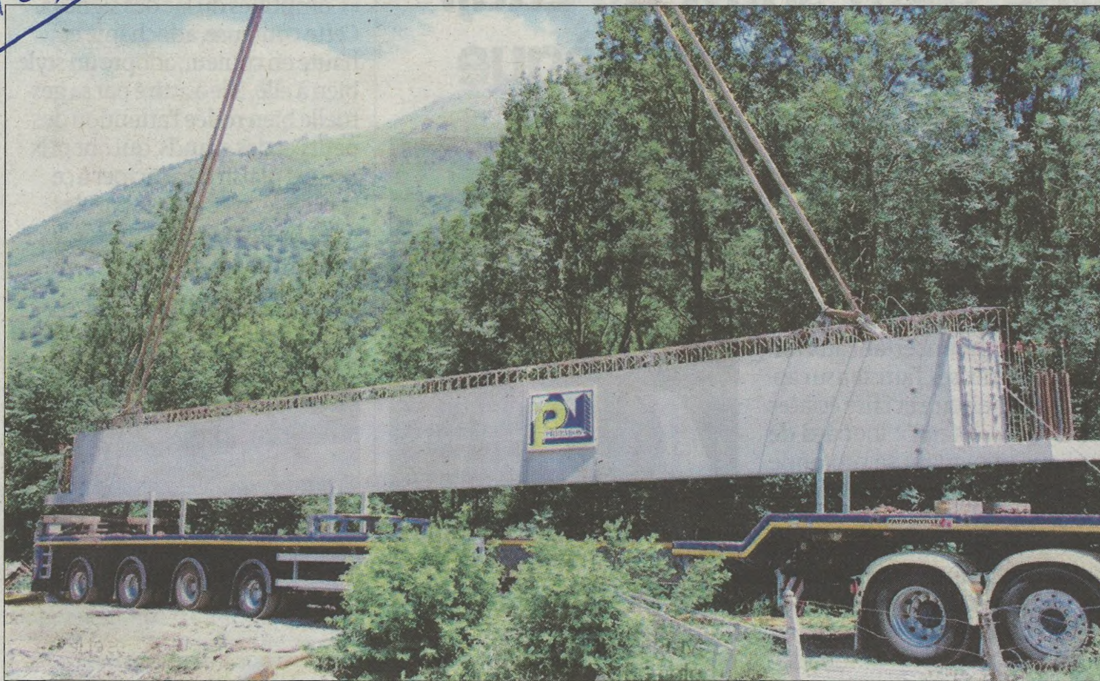
Les éléments ont fini d'arriver hier, sur le chantier de la voie ferrée. PHOTO DR
