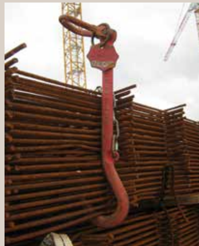
Fig. 15 Nœud de ferrailage prédalle suspendue
