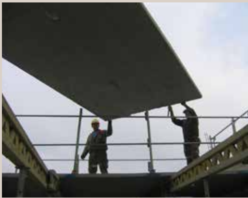
Fig. 8 Réception des prédalles, avec garde-corps montés au préalable
