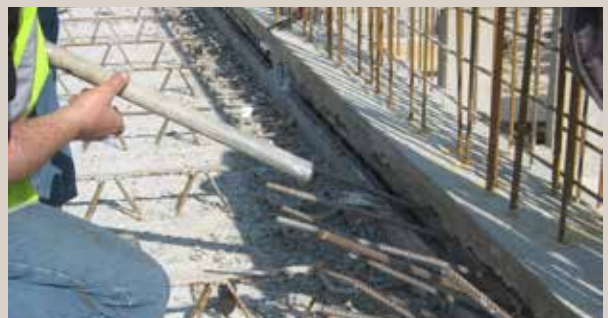
Fig. 16 Dépliage des armatures de liaison
