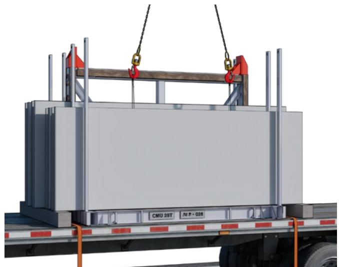
2°) Accrocher le prémur à l'appareil de levage.
